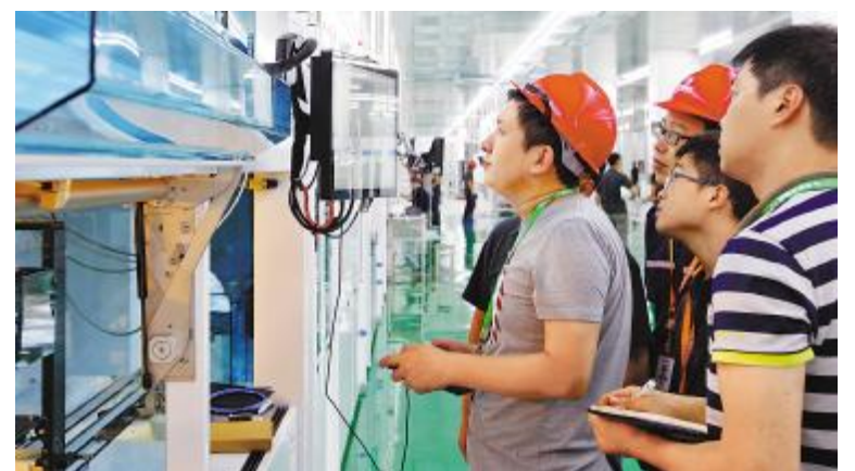
技术人员正对二期项目设备进行调试
