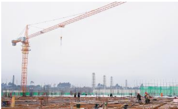
二期项目建设现场
