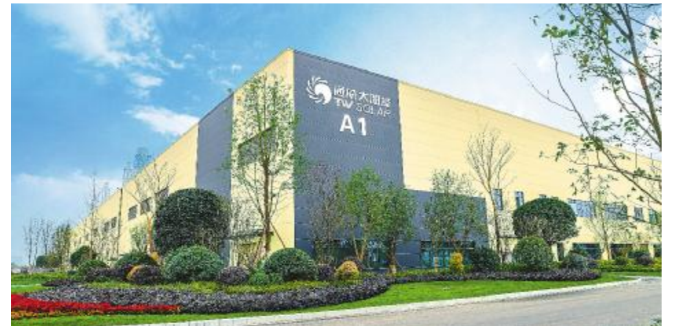
通威太阳能成都三期A1车间
